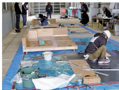
塩化ビニル系シート防水工事
