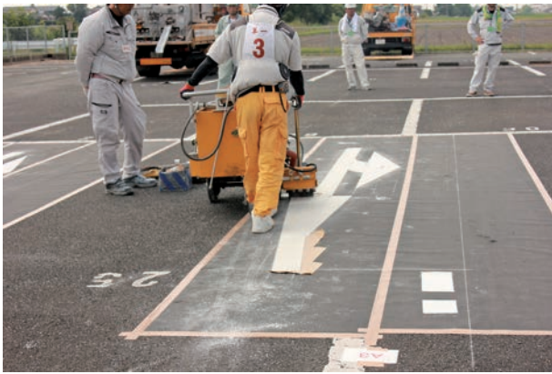
【溶融ペイントハンドマーカー工事】
