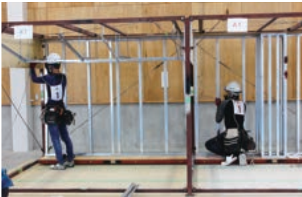
鋼製下地工事
