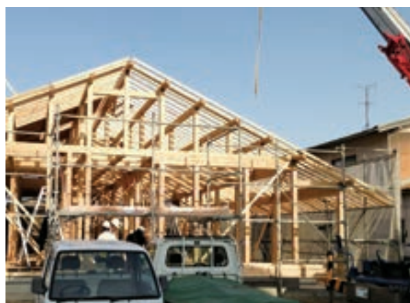
「グッドスキルマーク」の認定 建築現場
