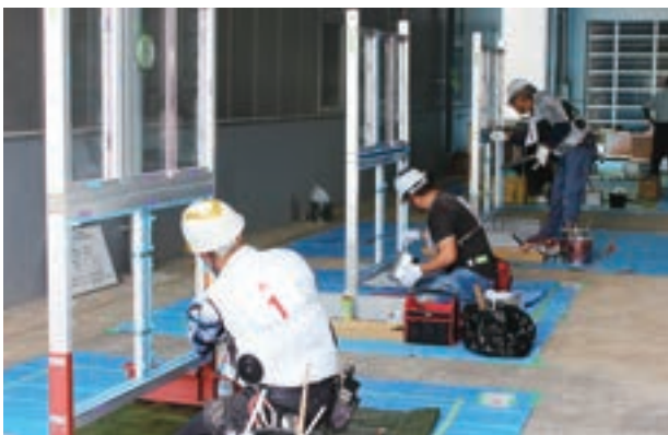
シーリング防水工事
