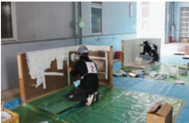
アクリルゴム系塗膜防水工事
