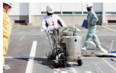
路面標示施工-溶融ペイントハンドマーカークイック作業
